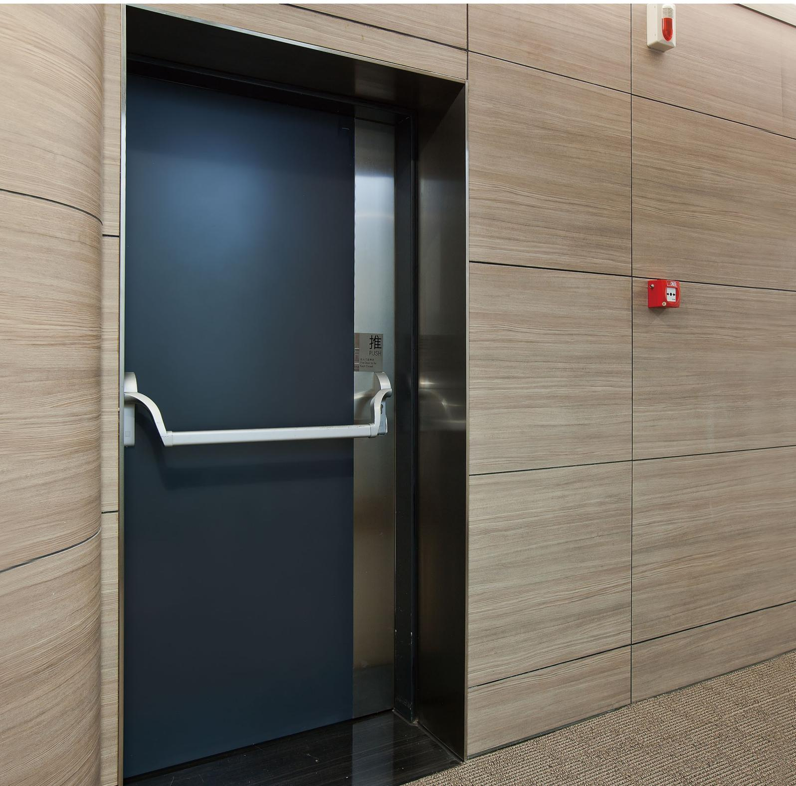
霍曼钢质防火门内部填充防火板，具有良好的防火和隔热性能，四周均嵌有防火膨胀条，可以有效的阻隔烟雾的蔓延。门扇可根据采光或逃生要求选配防火视窗、逃生推杠等，广泛应用于建筑物的防火区域。
