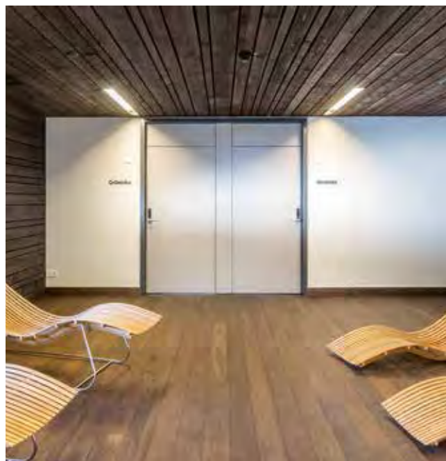
两扇门 – 通过整体门框达到一扇门的视觉效果。
