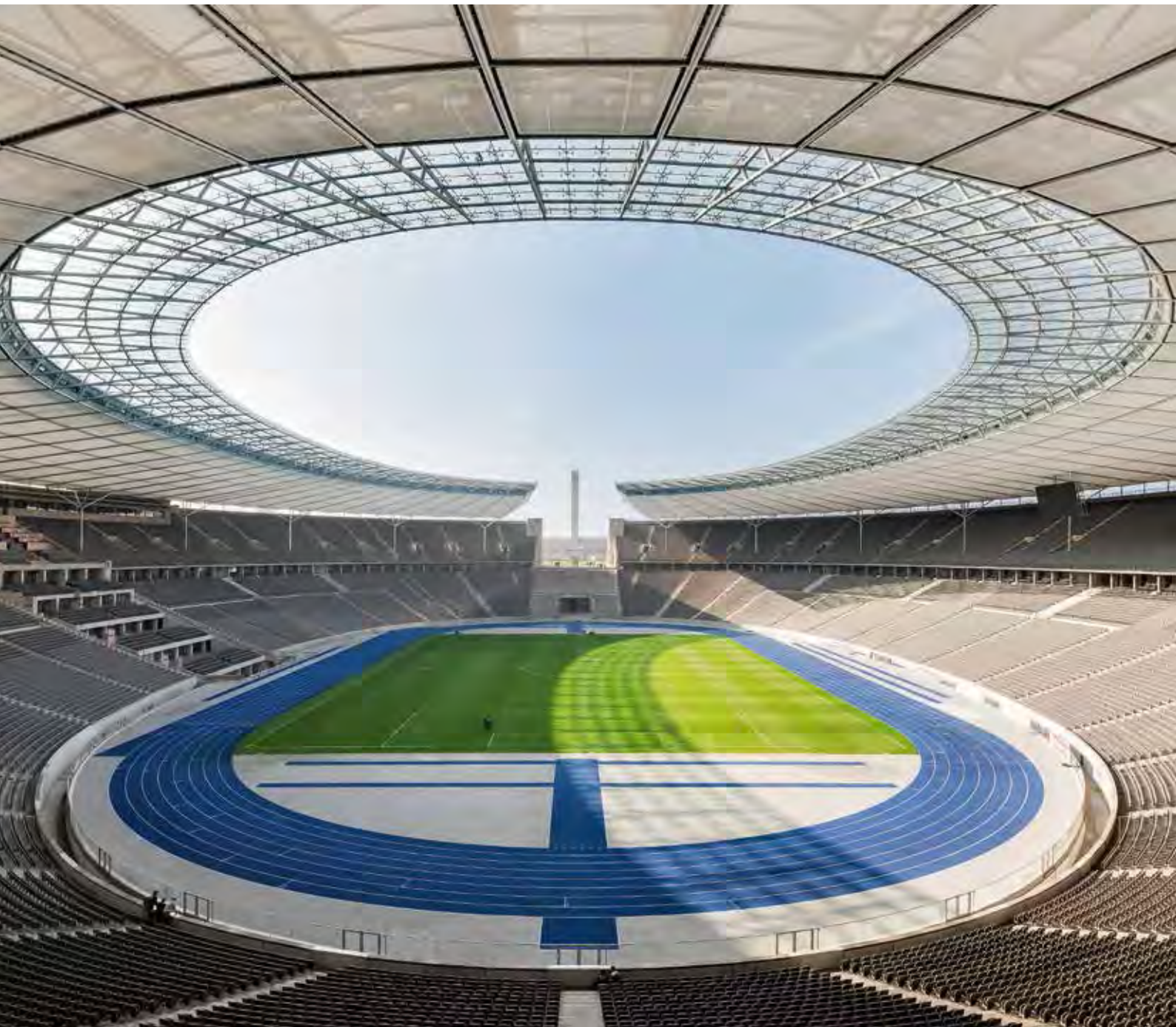
柏林奥林匹克体育场设计亮点：对称列于马拉松之门两侧、采光良好的膜结构天幕。
