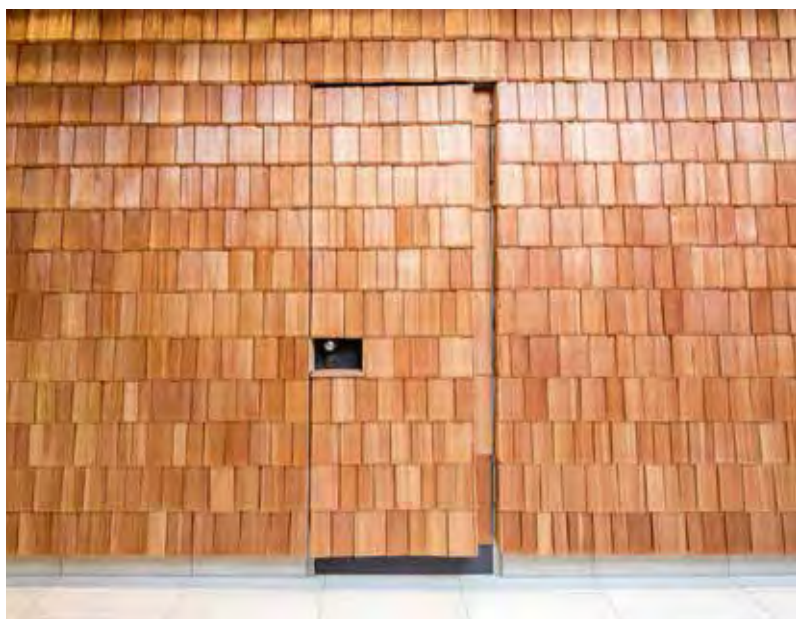
门的表面采用墙体相同材料并保持与墙面齐平，慧心巧思，浑然天成。
