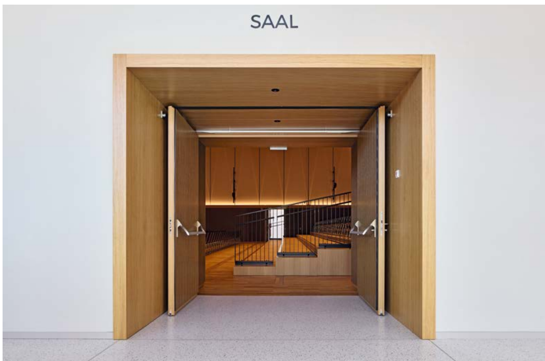
隔音效果佳：隔音门将音乐有效隔离在音乐厅内，确保音效不外泄。
