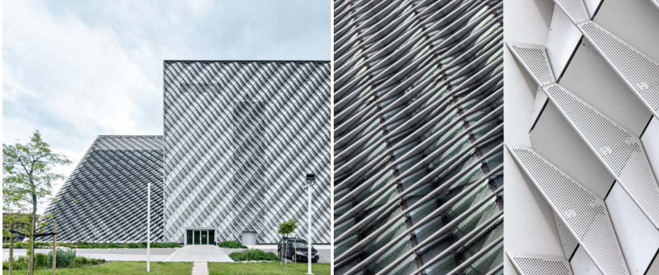
外表面让人联想到冰川的晶体结构，并由大量局部穿孔的金属板构成。
