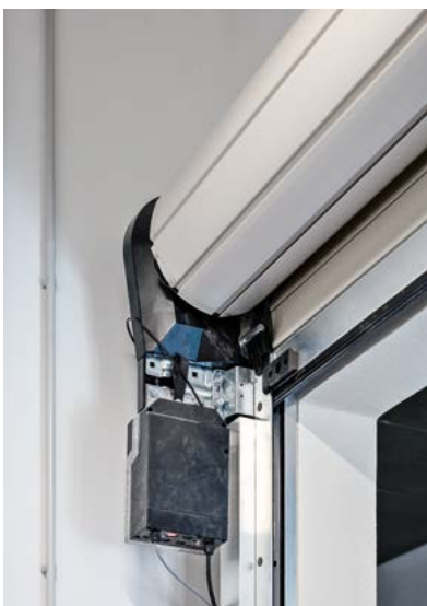
微型电机和获得专利的拉伸弹簧技术细节。
