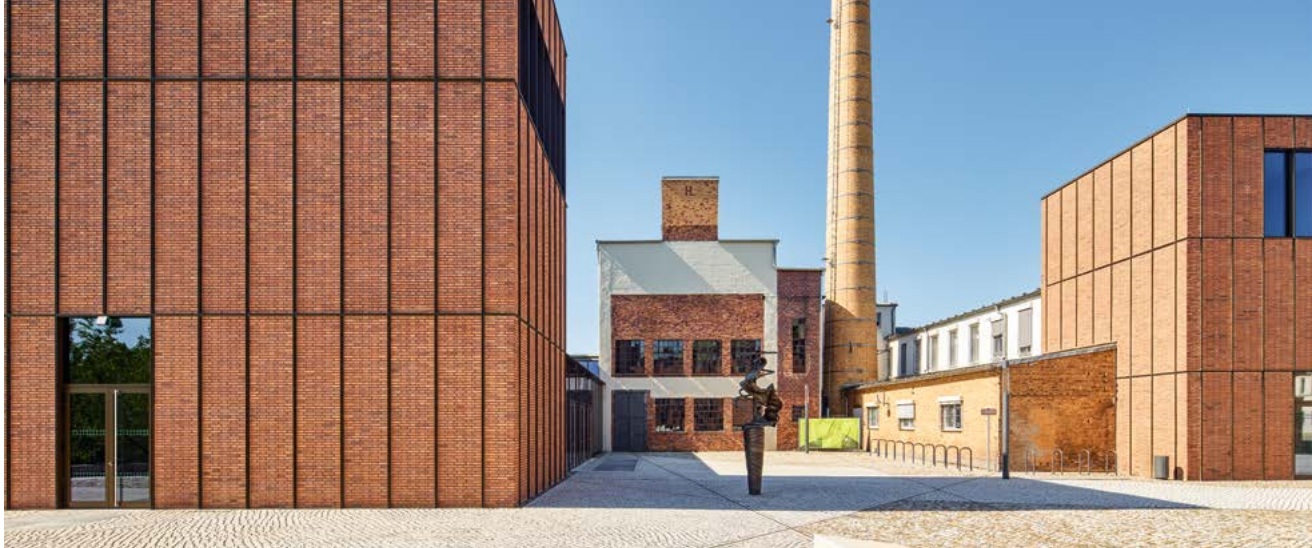
新建建筑的立面由结构铝合金型材构成，其间填充砖墙。
