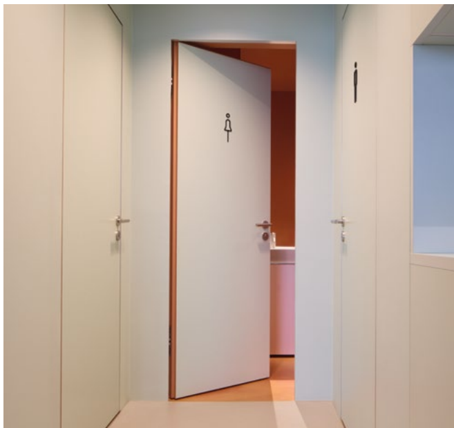
齐平安装的门营造出干净整洁的墙面设计。门面饰面可与墙面颜色进行同色匹配。
