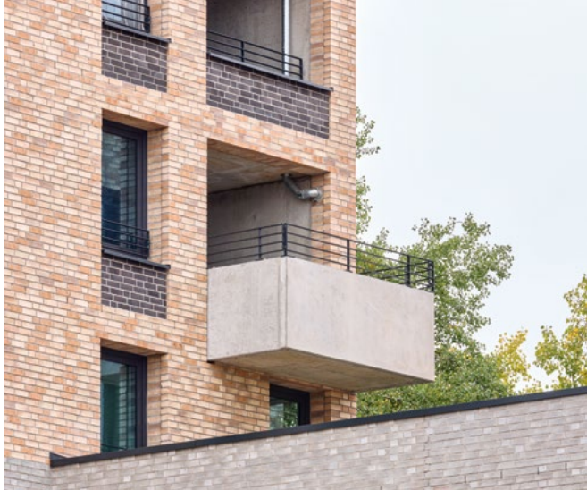
住宅塔楼下部的阳台从立面凸出。
