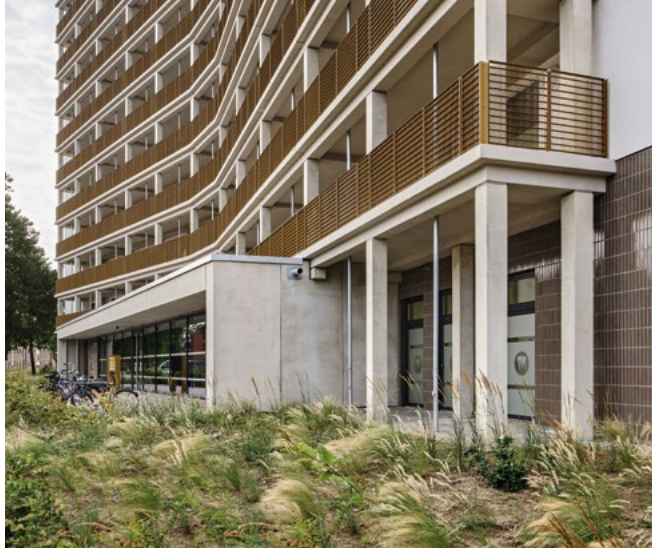
在建筑物的两侧长边，建筑师在原有建筑外侧增设了一座自承式预制钢筋混凝土结构。
